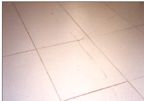
Fig. 4.112. Detalle de daños en solado de gres
