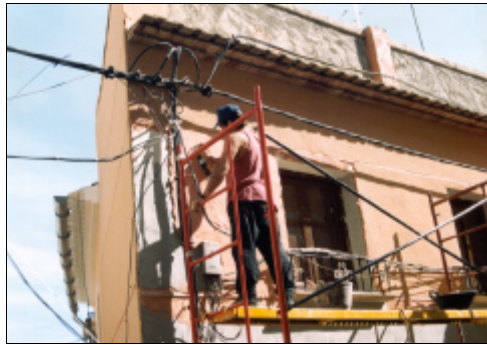
Fig. 4.121. Ejecución de mortero monocapa en la fachada de un edificio afectado por el seísmo
