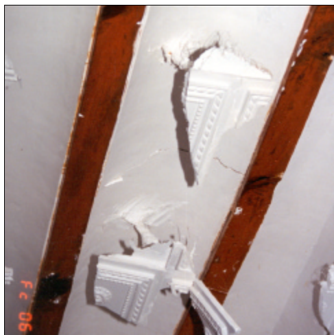
Fig. 4.58. Fisuras y grietas en revoltón perpendiculares a la vigueta sobre las que se apoya
