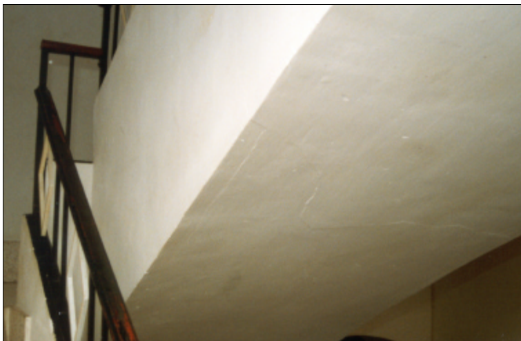
Fig. 4.63. Daños en el tablero de una zanca de escalera motivada por una flexión excesiva
