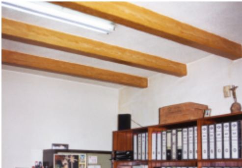
Fig. 2.62. Tipos de forjado: Viguetas de madera y doble tablero
