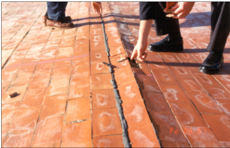
Fig. 4.90. Ejemplo del estado de la junta de la imperme- abilización y de piezas cerámicas en una cu- bierta plana
