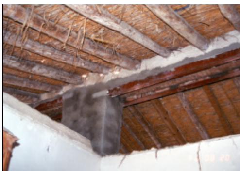
Fig. 4.75. Cumbrera que ha debi- do de ser reforzada tras el movimiento sísmico
