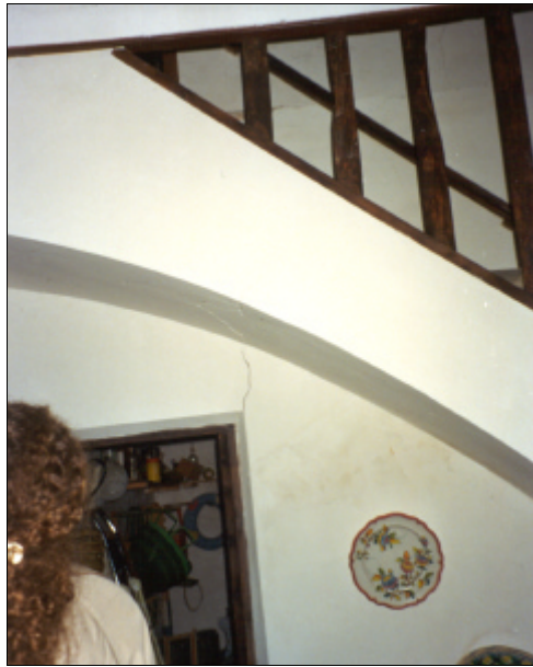
Fig. 4.68. Grieta en una zanca de escalera que alcanza ciertamente el tablero cerámico
