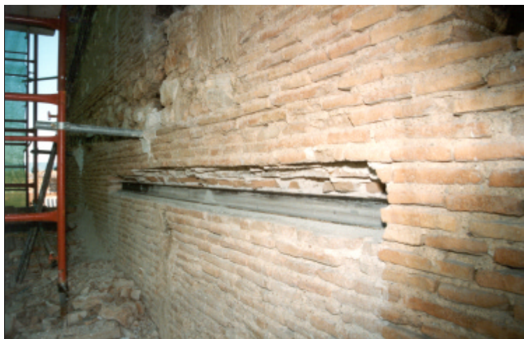
Fig. 4.29. Ejemplo de intervención mixta de grapado de una fábrica de ladrillo de gran espesor en la iglesia de Alguazas
