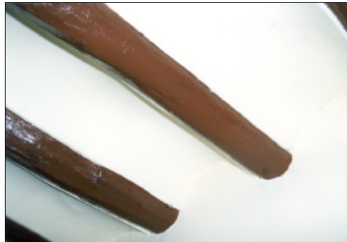
Fig. 2.64. Tipos de forjado: Rollizo de madera y revoltón
