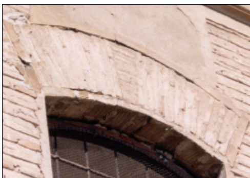
Fig. 2.96. Ejemplo de dintel en el que se ha utilizado un encofrado perdido ejecutando una rosca tabicada de ladrillo
