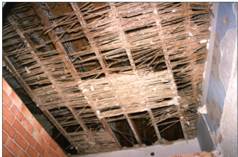
Fig. 4.113. Falso techo de cañizo una vez que ha sido demolida la parte que no había colapsado
