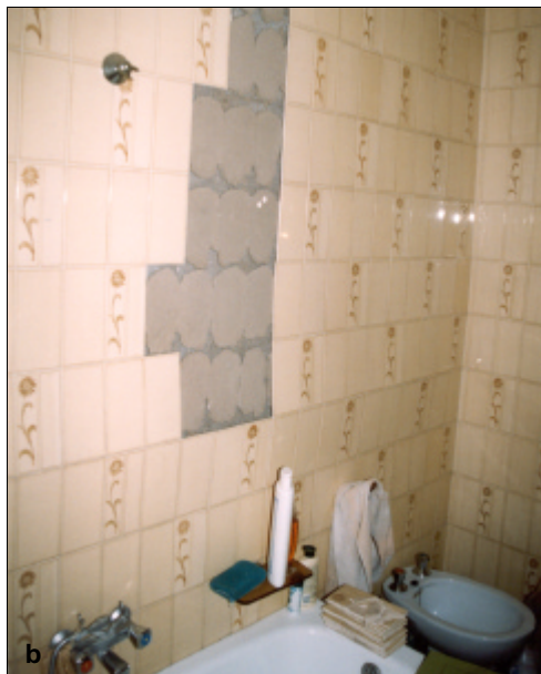
Fig. 4.109. Revestimiento cerámico dañado por efecto de un sismo
