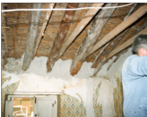
Fig. 4.38. Daños en paramentos por efecto de la flexión de las viguetas
