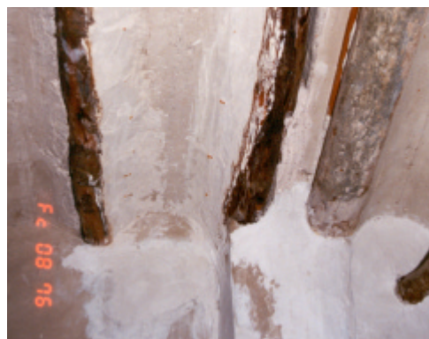
Fig. 4.40. Forjado en el que se ha restituido la forma a los revoltones, que sufrieron daños en el apoyo sobre las viguetas
