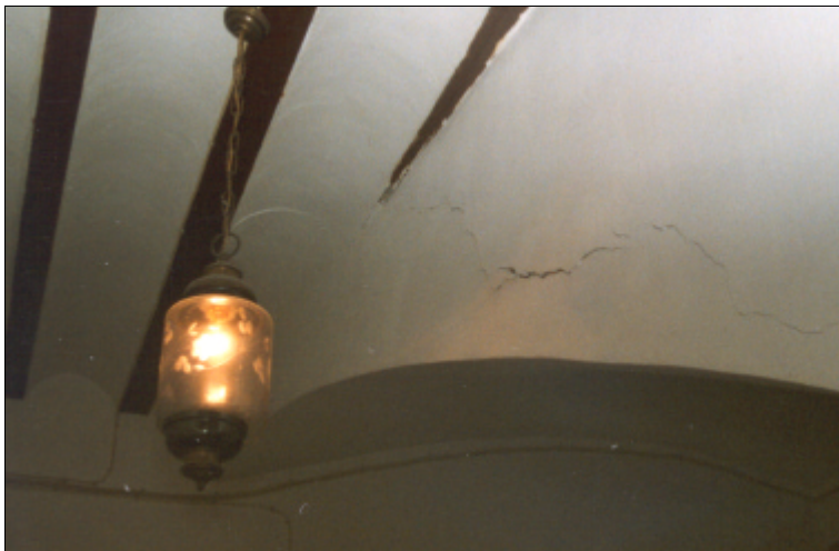
Fig. 4.64. Grieta entre el tablero de la escalera y la tabiquería dispuesta sobre ella, por incompatibilidad geométrica del conjunto al vibrar
