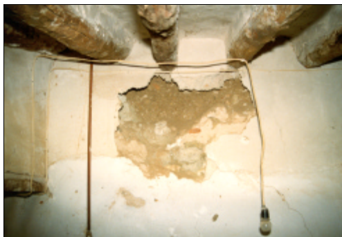
Fig. 4.19. Ejemplo de desplome parcial de un muro de tapial a consecuencia del seísmo
