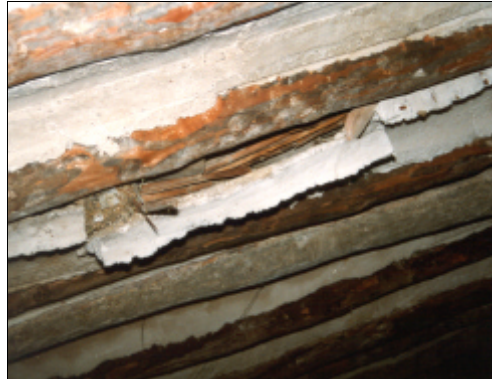
Fig. 4.41. Desprendimiento parcial de revoltón en un faldón de cubierta
