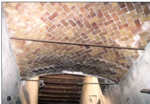
Fig. 2.100. Ejemplos de bóvedas tabicadas en la comarca del río Mula
