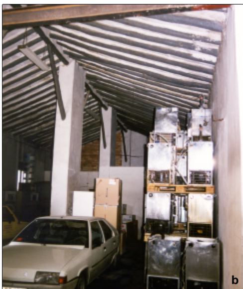
Fig. 2.83. Ejemplos de cubierta a dos aguas de correas:
