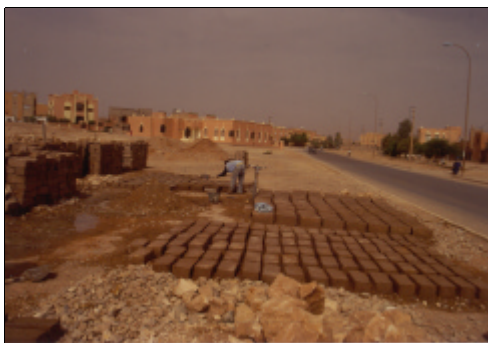
Fig. 2.27. Secado y apilado de los bloques de tierra compactada a pie de obra
