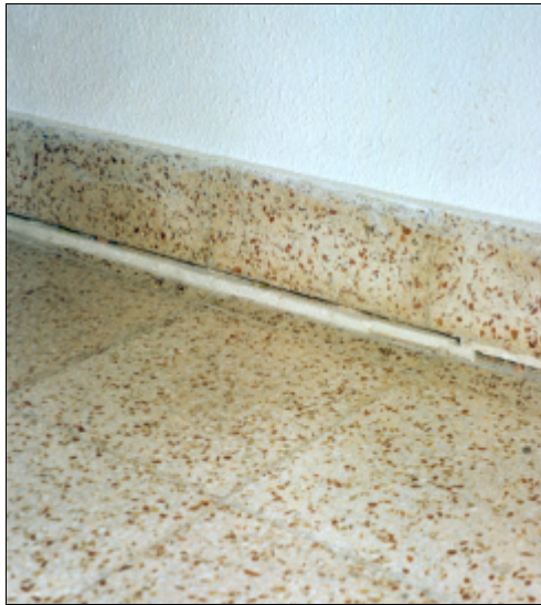
Fig. 4.102. Cesión del forjado bajo la tabiquería de modo que esta trabaja a fle- xión en su plano
