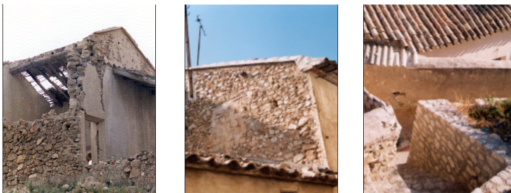
Figs. 2.38 2.39 2.40 Ejemplos de utilización de mampostería ordinaria encontrados en Mula
