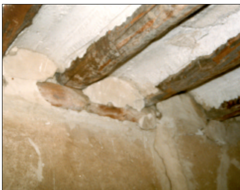
Fig. 4.37. Entrega de viguetas sobre un durmiente
