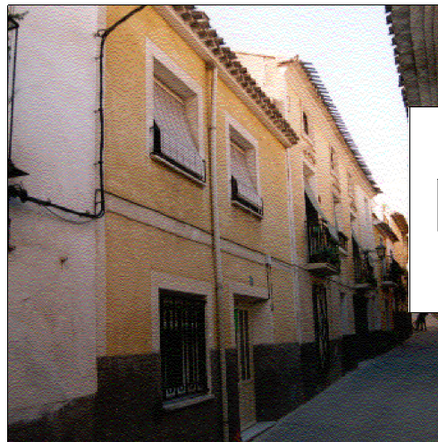
Fig. 2.17. Muros de carga parale- los a fachada
