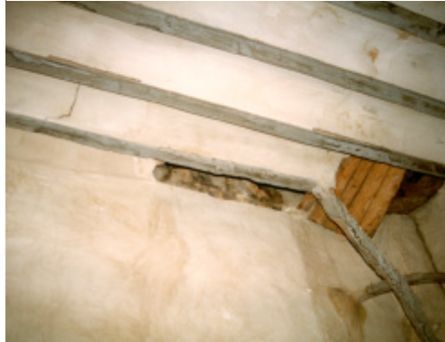
Fig. 4.42. Colapso de una sección de revoltón en un forjado
