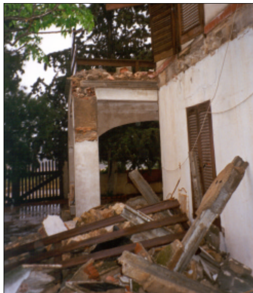
Fig. 4.2. Ejemplos de grietas con motivadas por el movimiento sísmico del 2 de febrero en edificios de la localidad de Mula
