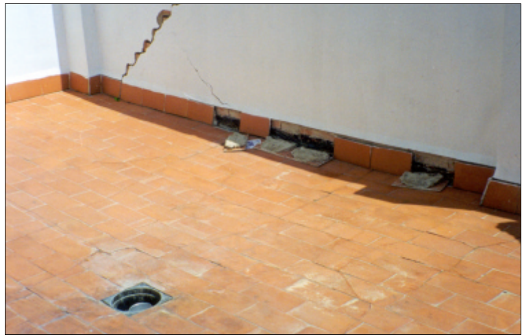
Fig. 4.92. Peto agrietado. Se puede apreciar el encuentro de la impermeabilización con el peto
