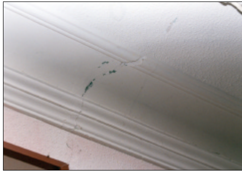
Fig. 4.116. Cornisa perimetral corrida ejecutada artesanalmente en falso techo de cañizo
