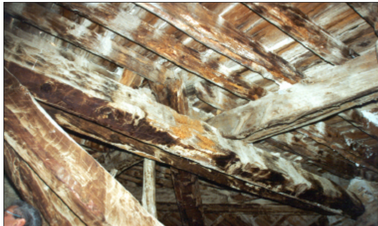
Fig. 4.77. Daños en la formación de pendiente.
