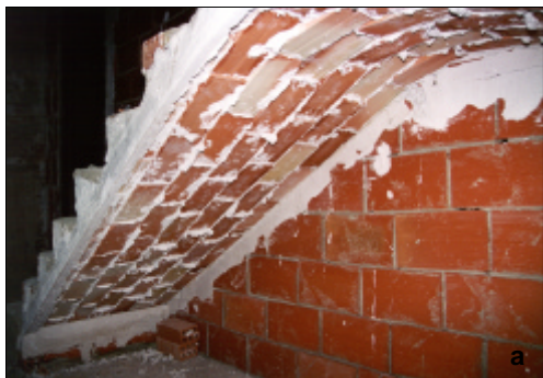
Fig. 2.106. Ejemplos de escaleras tabicadas de ladrillo
