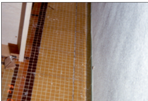
Fig. 4.45. Forjado que se ha plegado en correspondencia con la primera vigueta
