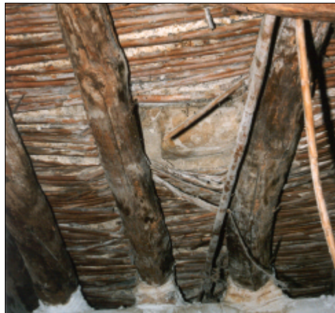
Fig. 4.77. Daños en la formación de pendiente.
