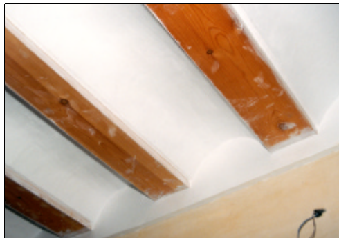
Fig. 2.66. Tipos de forjado: Vigüeta de madera labrada y revoltón
