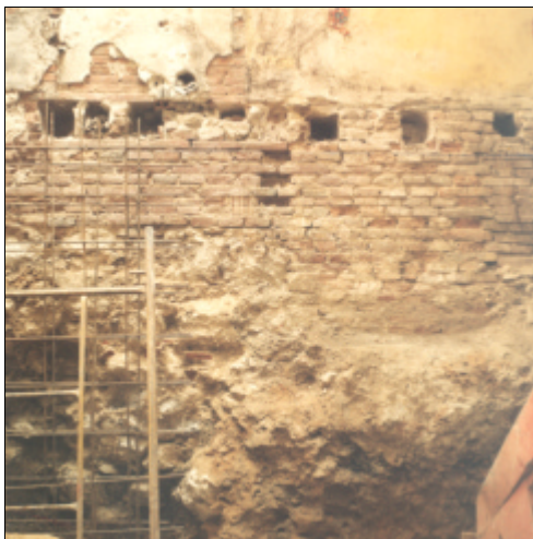
Fig. 2.13. Cimentación de cal y canto
