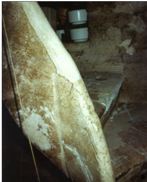
Fig. 4.69. Incompatibilidad geométrica al vibrar, de unidades de obra construidas sobre el tablero cerámico de una escalera
