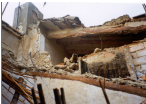
Fig. 4.73. Cubierta parcialmente derruida por efecto del seismo del 2 de febrero
