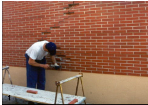
Fig. 4.31. Taqueado de un muro de ladrillo
