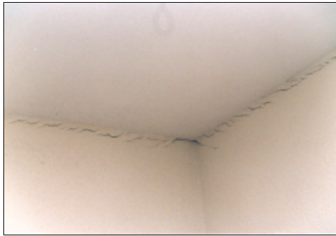
Fig. 4.101. Grieta en el encuentro entre tabiquería y forja- do
