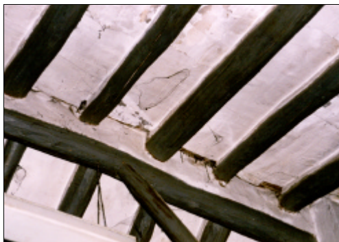
Fig. 4.76. Apoyo de viguetas en caballete
