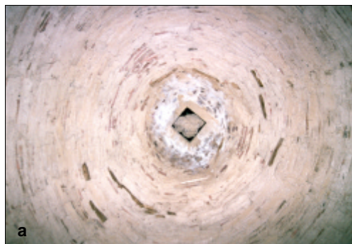
Fig. 2.102. Esbeltez máxima de una bóveda semiesférica
