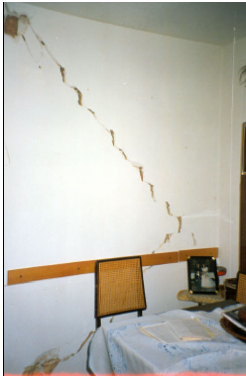
Fig. 4.98. Rotura típica de tabique en forma de aspa por haber sido solicitada en los dos sentidos opuestos en una dirección contenida en su plano
