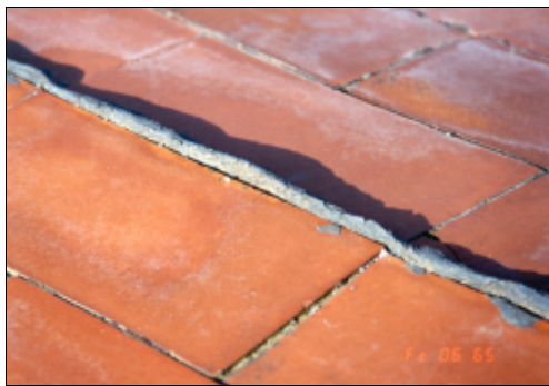
Fig. 4.89. Estado de una junta en el cambio de pendiente de cubierta plana
