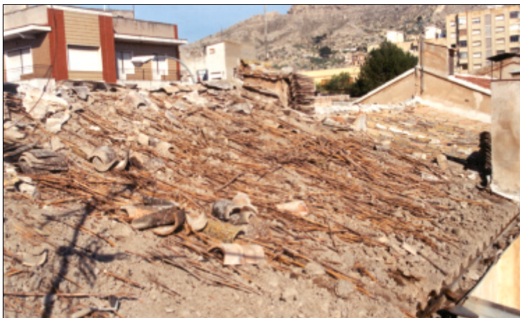
Figs. 4.83. y 4.84 Daños en la formación de pendiente
