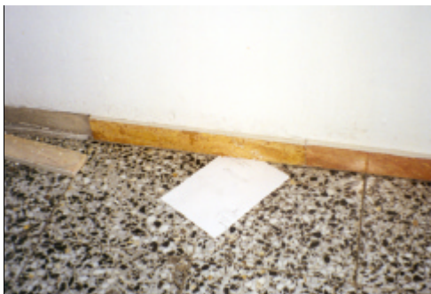
Fig. 4.44. Flexión de forjado motivada por el sismo
