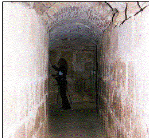
Fig. 2.99. Bóveda de rosca apa- rejada, de sección cir- cular rebajada
