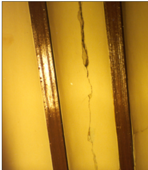
Fig. 4.57. Grieta en revoltón paralela su directriz
