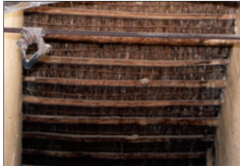
Fig. 2.75. Tipos de cubierta a un agua: faldón a la molinera
