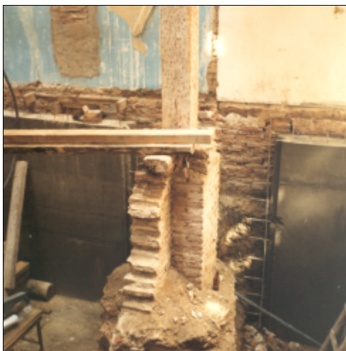
Fig. 2.14. Cajón de cimentación
