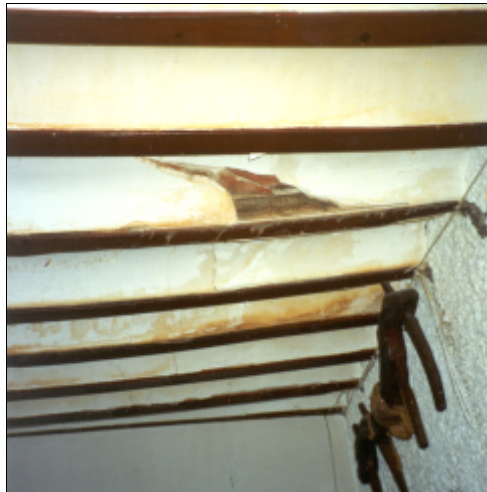
Fig. 4.56. Desprendimiento parcial de un revoltón
