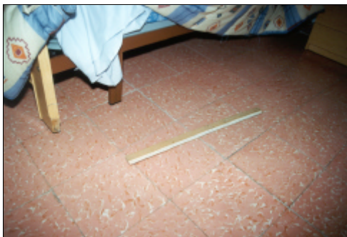
Fig. 4.43. Ejemplo de forjado dañado por la rotura de una de las viguetas de madera que lo componen
