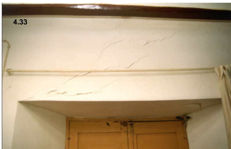
Figs. 4.32 y 4.33 Ejemplos de dinteles afectados por el movi- miento sísmico en viviendas del núcleo urbano de Mula
