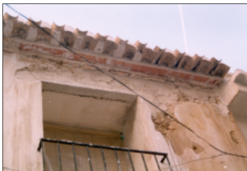
Fig. 4.20. Reconstrucción parcial de fachada de mampostería con funciones portantes
