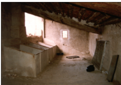
Fig. 2.77. Ejemplos de cubiertas a un agua: Faldón de correas sobre jácenas
