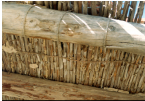
Fig. 2.74. Formación de cubierta y material de cobertura en una cubierta tradicional inclinada con acabado interior
