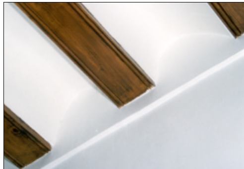
Fig. 2.65. Tipos de forjado: Rollizo de madera con mentidor y revoltón
