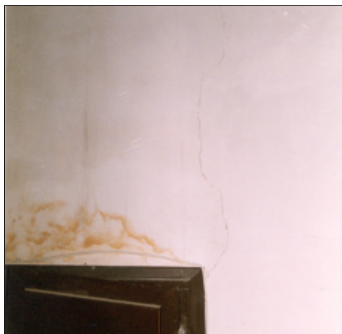
Fig. 4.100. Agrietamiento en el ángulo de un hueco para carpintería
