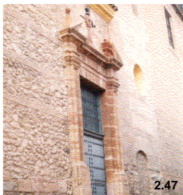
Figs. 2.47 y 2.48. Ejemplos de sillería
