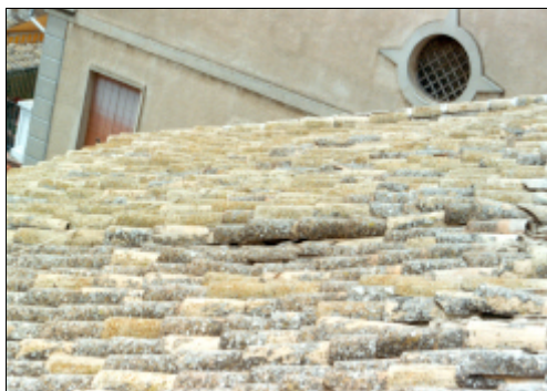
Fig. 4.74. Efecto de la rotura de un par de cubierta en la geometría del faldón
