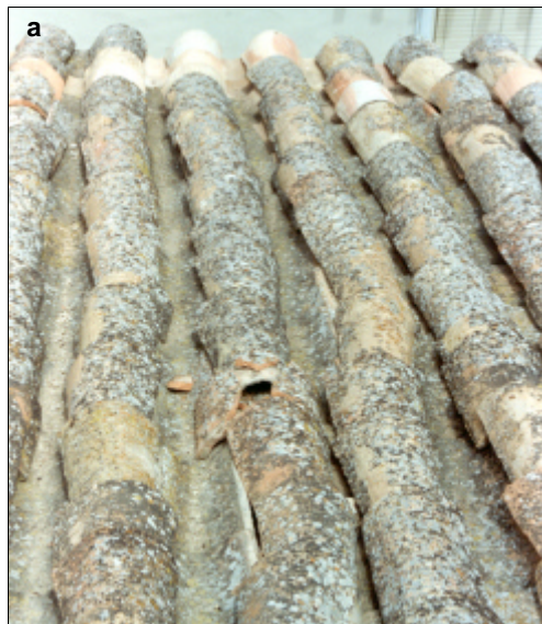
Fig. 4.79. Daños en el material de cobertura
