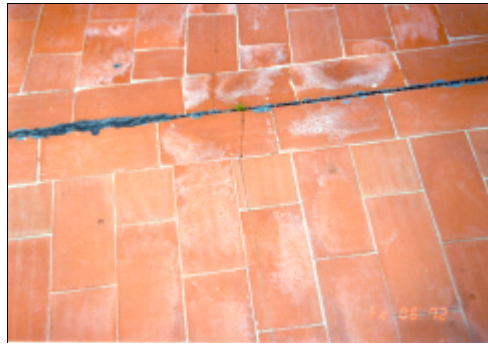
Fig. 4.91. Impermeabilización y baldosas cerámicas dañadas
