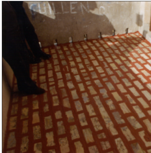
Fig. 4.95. Forma de reparación de la pérdida de estanqueidad incorrecta
