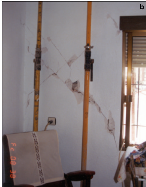
Fig. 4.17. Rotura de elementos murarios
