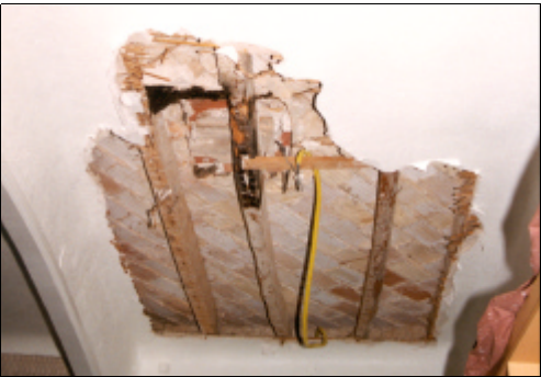
Fig. 2.63. Tipos de forjado: Vigueta de madera y tablero de rasillas
