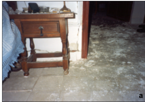
Fig. 4.111. Pérdida de planeidad de un solado por efecto de un sismo
