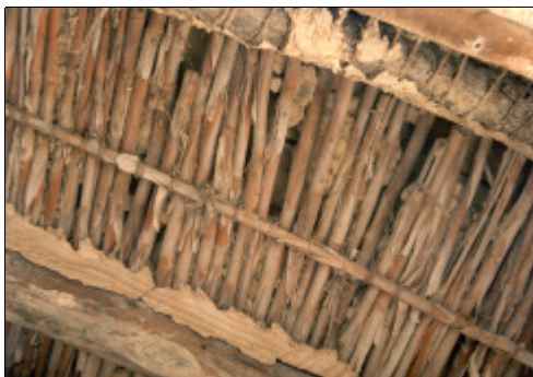
Fig. 2.72. Formación de cubierta y material de cobertura en una cubierta tradicional inclinada sin acabado interior
