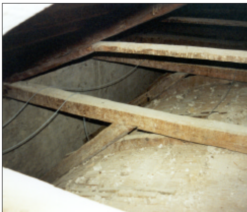
Fig. 2.101. Ejemplos de bóvedas encamonadas
