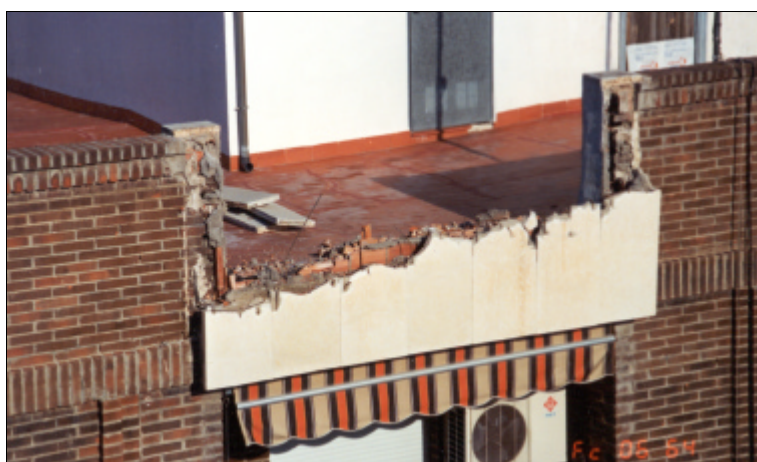
Figs. 4.93. y 4.94 4.93. Balastrada en remate de cubierta que se ha visto afectada
