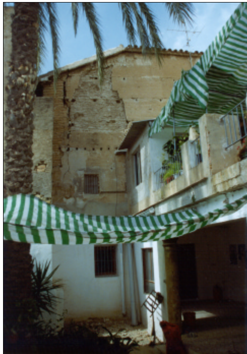
Fig. 4.118. Revestimiento desprendido a consecuencia del sismo
