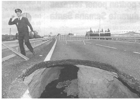
Fig. 4.14. Cesión del terreno debida a la rotura de la red de saneamiento provocada por el movimiento sísmico
