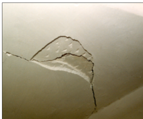
Fig. 4.108. Detalle del acabado interior en un dintel, descubierto en el momento de sanear la grieta aparecida por el movimiento sísmico
