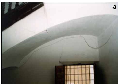
Fig. 4.65. Escalera de cuatro tramos dañada por el movimiento sísmico
