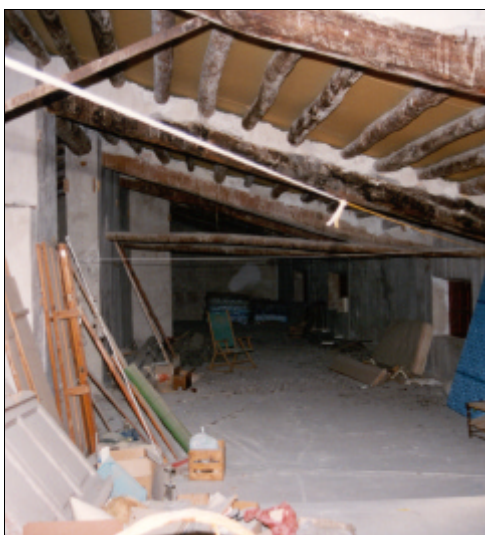
Figs. 4.83. y 4.84 Daños en la formación de pendiente
