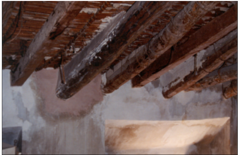
Figs. 4.53 y 4.54. Movimiento de la entrega de las viguetas sobre el muro de apoyo en una vivienda del centro de Mula
