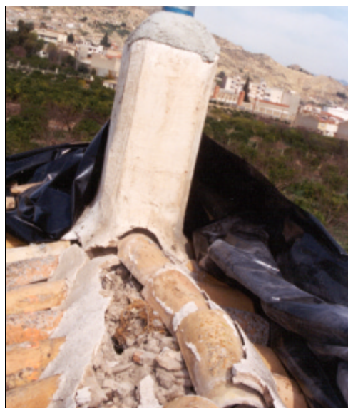
Fig. 4.78. Remate de teja de cumbrera en ruina como consecuencia del movimiento sísmico
