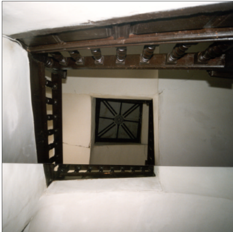
Fig. 4.65. Escalera de cuatro tramos dañada por el movimiento sísmico
