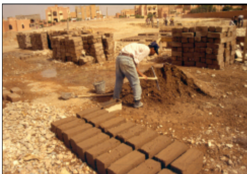
Fig. 2.26. Fabricación de bloques de tierra compactada
