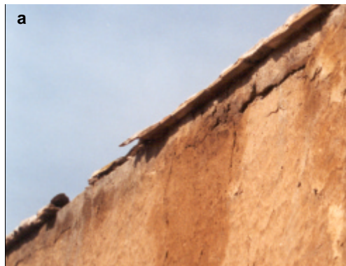
Fig. 4.80. Daños en el remate de borde en el hastial
