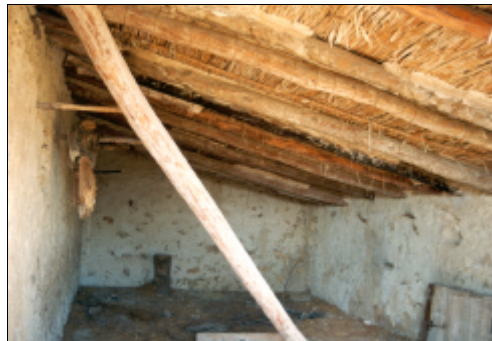
Fig. 2.76. Tipos de cubierta a un agua: faldón de pares
