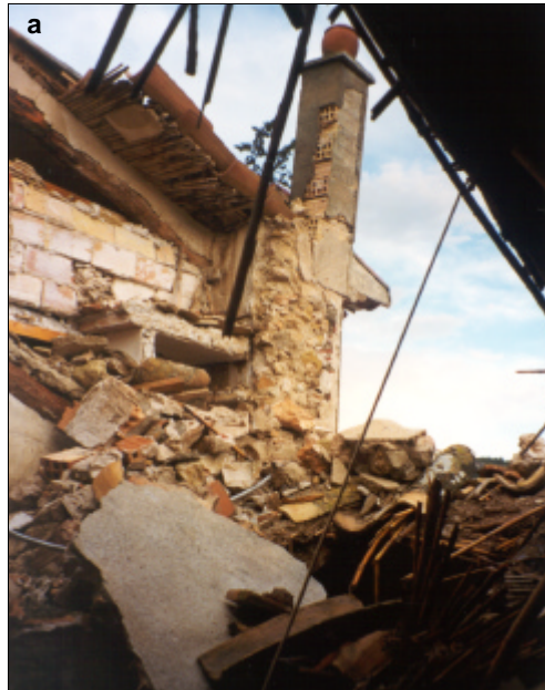
Fig. 4.16. Colapso parcial de estructuras murarias
