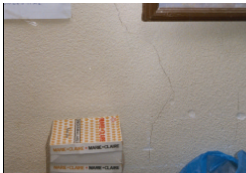
Fig. 4.99. Fisuración de tabiquería por una sola de sus caras, por efecto del seísmo
